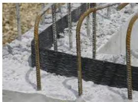
A junta CEMflex VB também pode ser inserida no betão fresco. As sobreposições devem ser corrigidas apenas usando o clipe CEMflex. A sobreposição tem que ser pelo menos 5 cm; não é necessário colar!
