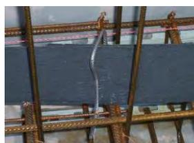
Junta Waterstop em aço CEMflex VB (com suporte CEMflex  $\Omega$ )
