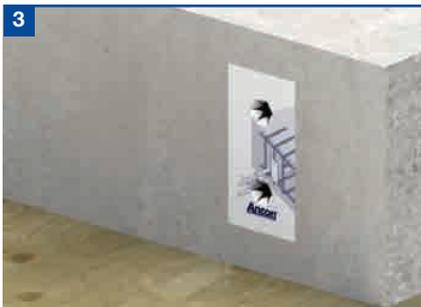
3 Quando o betão ter atingido a cura suficiente, descofrar. Descolar ou perfurar o selo para expor os furos para as cavilhas. Quando estiverem a aplicar conectores do tipo "Q", o rótulo só deve ser perfurado o suficiente para permitir que a cavilha entre na manga cilíndrica para evitar que os detritos entrem na secção de caixa
